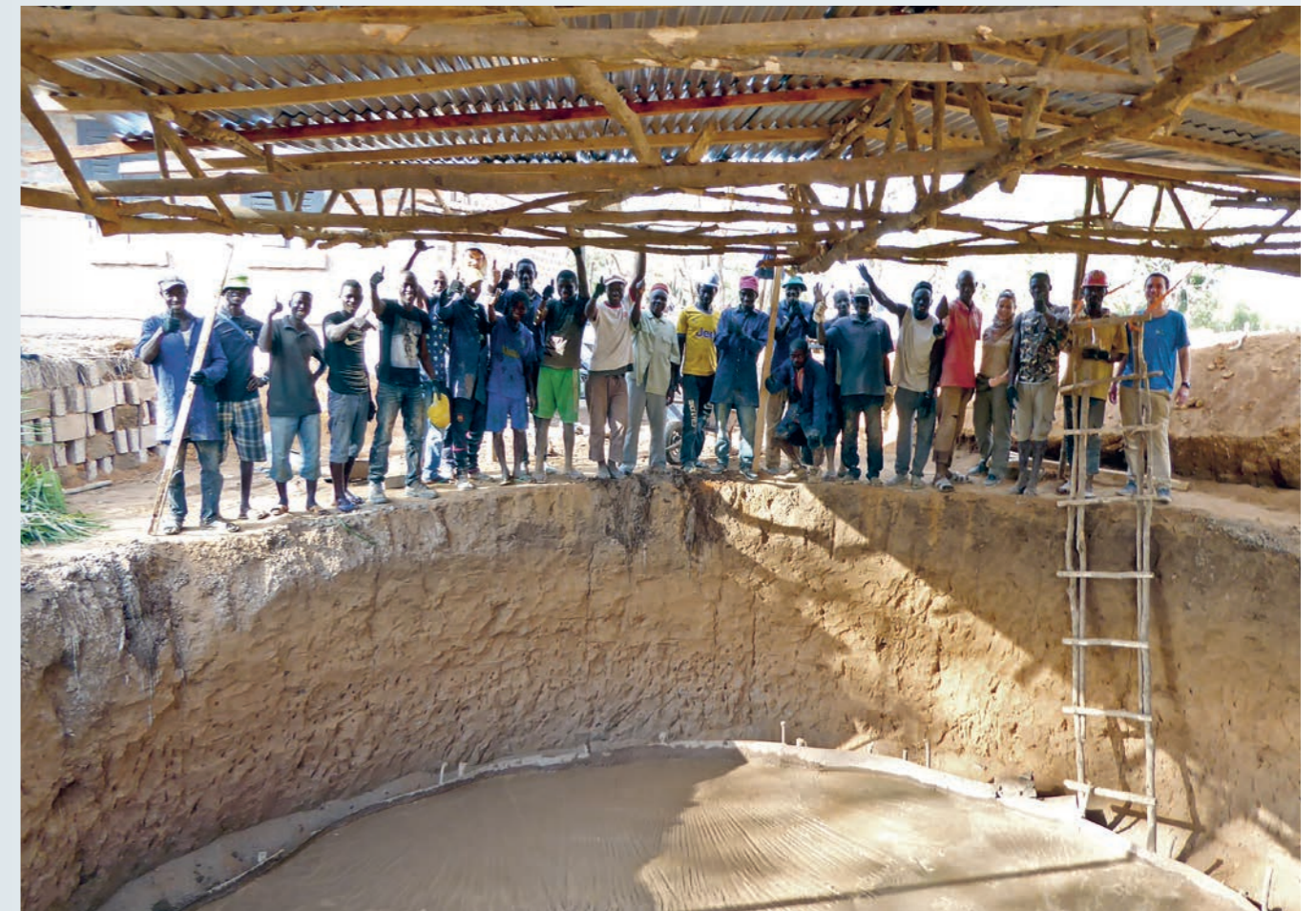
Die Bodenplatte ist gegossen – zufriedene Arbeiter und das Team von Ingenieure ohne Grenzen e.V. beim Bau einer Regenwasserzisterne für eine Grundschule in Kanty, Guinea, im März 2018. / The floor slab is cast – satisfied workers and the team from Engineers Without Borders building a rainwater cistern for a primary school in Kanty, Guinea, in March 2018.
